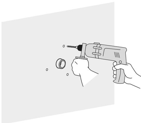
5. Retirer l'applique et percer le mur au niveau des marques.
