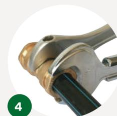
**4** Serrer l'écrou sur le corps du raccord à l'aide de deux clés.
